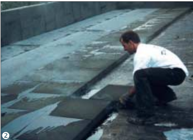
2 Verlegen der FOAMGLAS®-Platten in Heißbitumen im Verband, vollflächig aufgeklebt und mit vollsatt verklebten Fugen.
