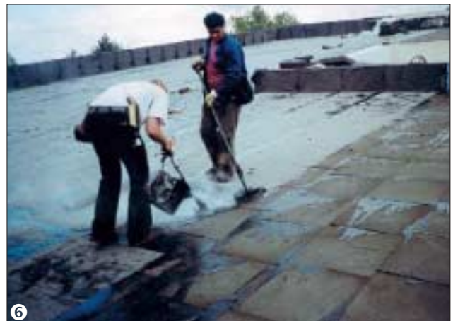
6 Aufkleben der ersten Lage Dachabdichtungsbahn im Gieß- und Einrollverfahren mit Heißbitumen .
