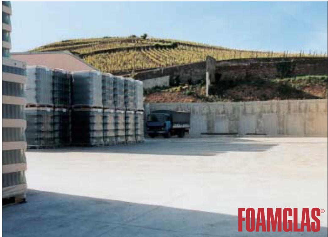
Winzerei Trimbach in Ribeauvillé (68), Frankreich. Dämmung einer Hofkellerdecke für Schwerlastverkehr mit FOAMGLAS®-Platten S3 in 10 cm Dicke.
