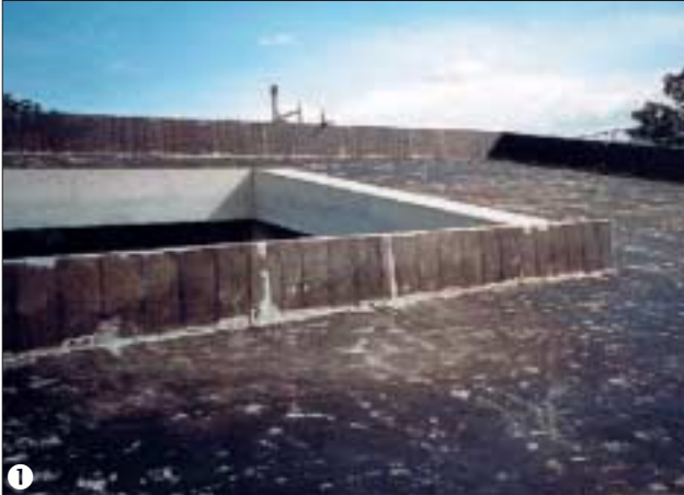
1 Ein Bitumenvoranstrich ist auf das flach geneigte Betondach als Haftgrund aufgetragen.
