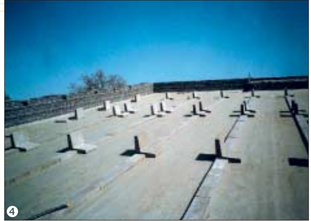
4 An den in regelmäßigen Abständen eingebauten Betonpollern werden später Stützen als Rankhilfe für die Rebstöcke befestigt.
