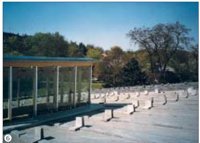
6 Später werden in Gebäudelängsrichtung Rankdrähte gespannt, an denen die Rebstöcke in horizontaler Richtung wachsen können.
