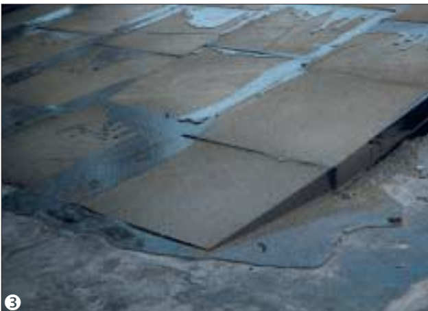
3 Um der Betondecke in Teilbereichen ein anderes Gefälle zu geben, werden neben Flachplatten auch FOAMGLAS®-Gefälleplatten verlegt.
