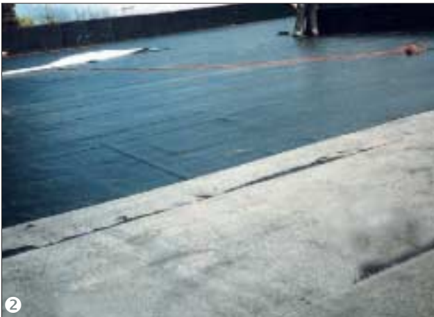
2 Zusätzlich zur Abdichtung aus Bitumendachbahn kommt eine bitumenverträgliche Schutz- und Wurzelschutzfolie zur Anwendung.
