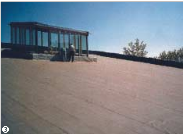
3 Die Folienbahn wird - wie auch die Bitumendachbahn - im Attikabereich hochgezogen.
