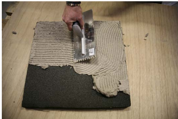
Abb. 1. Auftragen des Klebers UNILIT ® K/2
