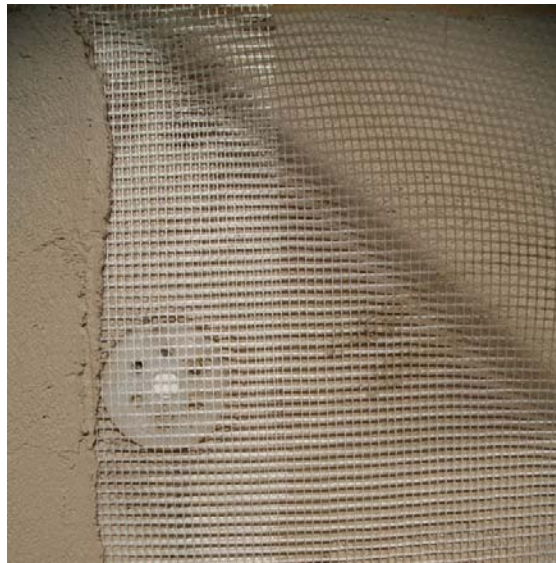
Fig 2. Glasfasergitter LIMETICS® PC150 und mechanische Sicherungen EJOTHERM® STRU
