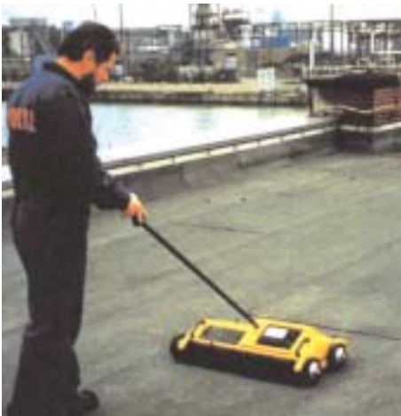
Mit dem Deckscanner zerstörungsfreie Feuchteanalyse.
