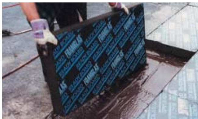
Alternative Kompaktdach-Verklebung der FOAMGLAS®-READY BOARDS mit PC® 58.
