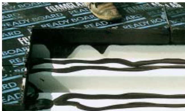
Streifenweise Verklebung der FOAMGLAS®-READY BOARDS mit PC® SK-FIX Kleber auf den Obergurten der Trapezfläche.
