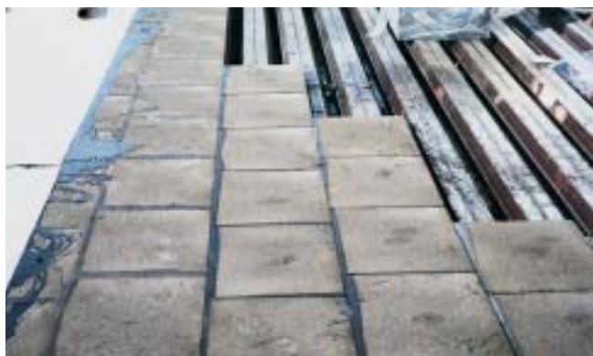
Verlegung der FOAMGLAS®-Platten auf Trapezprofilblech.
