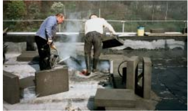
Der Neuaufbau der Dachfläche erfolgt mit FOAMGLAS®-Gefälleplatten.
