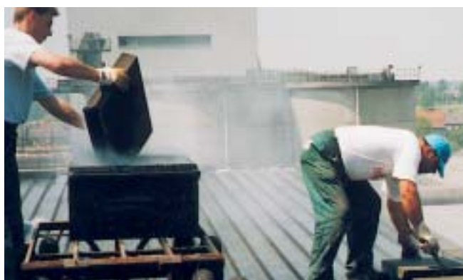
Verlegung der FOAMGLAS®-Platten im Heißbitumen-Tauchverfahren; Stoßfugen sind bitumengefüllt.
