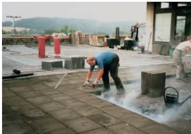
Verlegen der FOAMGLAS®-Gefälleplatten im Kompaktdach-Verfahren als Zusatzdämmung auf vorhandenem Dämm-/Abdichtungsaufbau.
