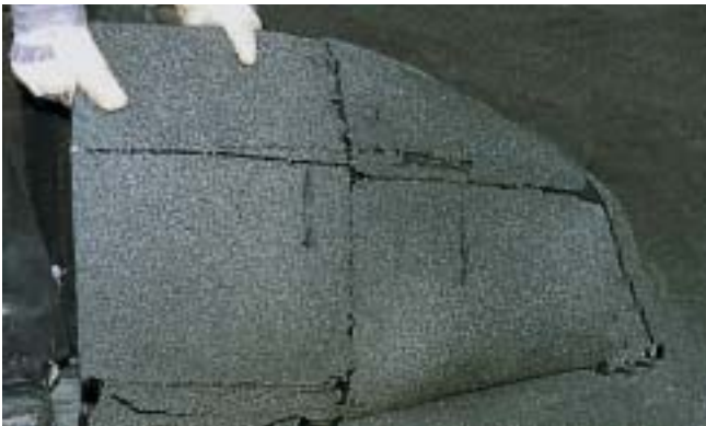
Die Bitumendachbahnen lassen sich abschnittsweise abschälen und aufnehmen.
