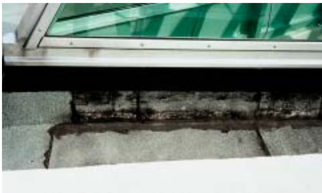
Abriß der Dachabdichtung am Dachrand/Lichtkuppel.
