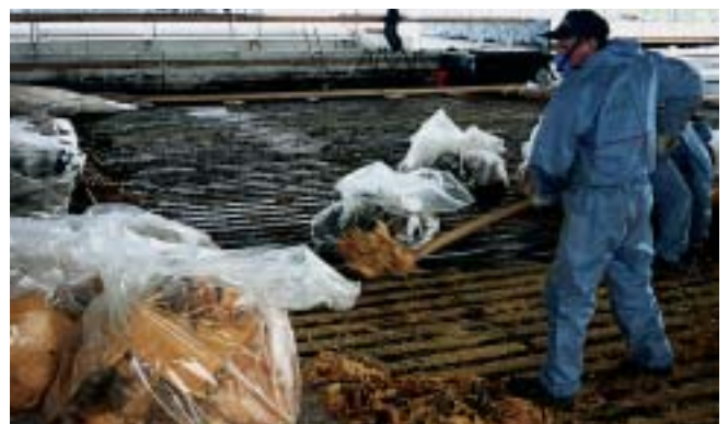
Mit Arbeitsschutzmaßnahmen wird ein Mineralfaser-Dach saniert.
