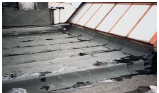
Ansicht der kompakt verlegten ersten Abdichtungslage.
