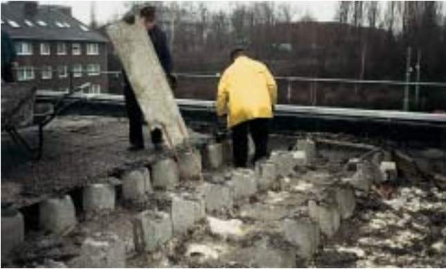
Abriss der Holzschalung (Kaltdachkonstruktion).
