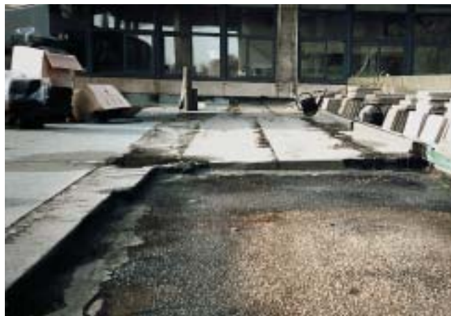
Tagesabschluss: Die 1. Lage Abdichtung wird über die FOAMGLAS®-Wärmedämmung auf die alte Abdichtung heruntergeführt, um eine Wasserunterläufigkeit auszuschließen.
