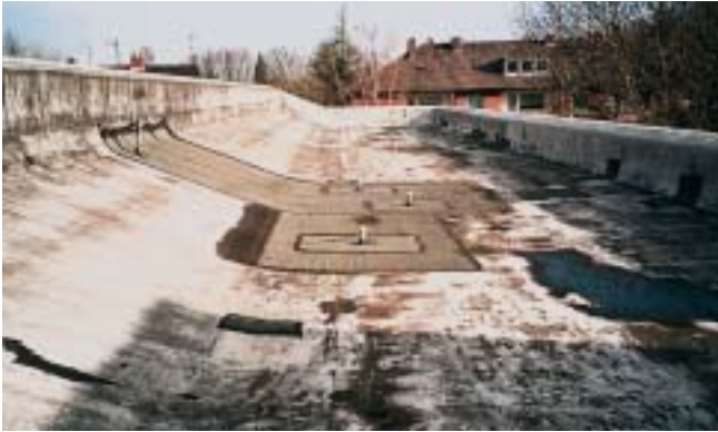
Die schadhafte Abdichtungsebene wurde teilflächig ausgebessert.
