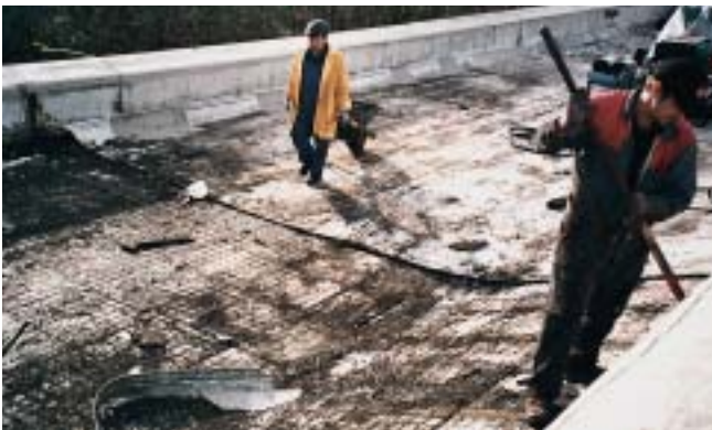
Unvermeidbar: Abriss der schadhaften Abdichtung sowie Aufnahme der „abgesoffenen“ EPS-Dämmung.
