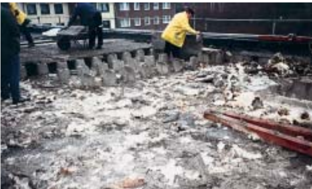
Die Ständerkonstruktion musste abgetragen werden, um die nasse Mineralfaser zu „bergen“ und zu entsorgen.
