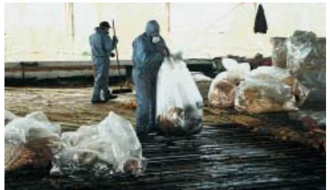
Abräumen der Mineralfaser-Altdachdämmung mit Atemschutz.
