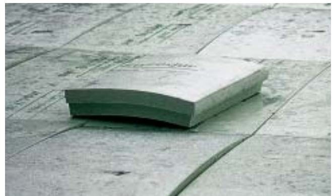
Schüsseln schon während Baustellenbetrieb.
