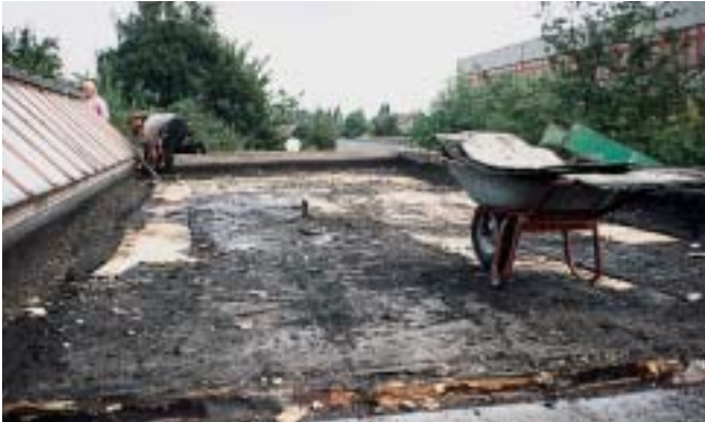
Abdichtung aufgenommen – PUR-Dämmung freigelegt.
