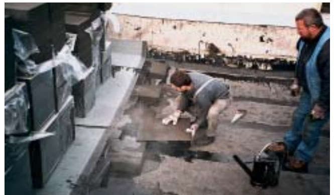
Sattes vollflächiges Einschwemmen der FOAMGLAS®-Platten.
