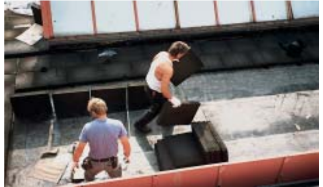
Vorarbeiten zur kompakten Verklebung der FOAMGLAS®-Gefälledämmung auf der Dachfläche.
