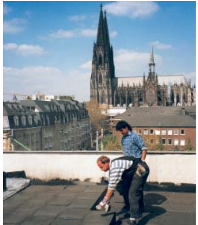
Verlegung der FOAMGLAS®-Gefälleplatten.
