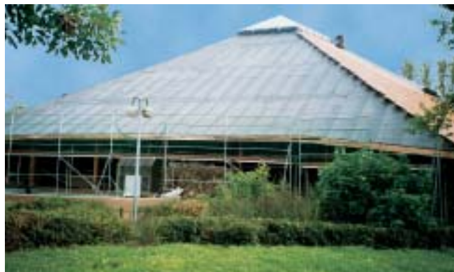
Sanierung mit FOAMGLAS® Metaldach-BOARDS verkürzte die Bauzeit.
