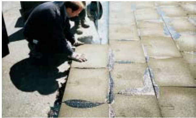
Verlegung der FOAMGLAS®-Gefälleplatten; Plattentyp und Gefällerichtung sind eindeutig gekennzeichnet.
