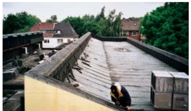
Anschlussarbeiten der neuen Abdichtungslage werden auf der Dachfläche ausgeführt.
