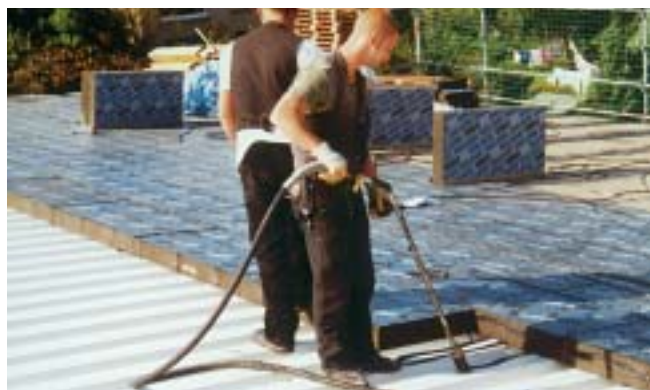
Verlegung FOAMGLAS®-READY BOARDS auf Trapezprofilblech mit Adhäsiv-Bitumen-Kaltkleber PC® 11.
