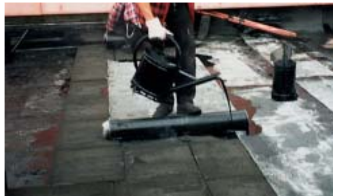
Aufbringen der ersten Abdichtungslage im Gieß- und Einrollverfahren.
