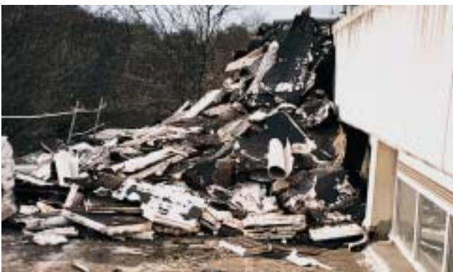
Zwischenlagerung der nassen EPS-Dämmung bis zur Entsorgung.
