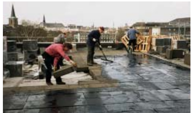
Aufbringen des Heißbitumen-Deckabstrichs auf die FOAMGLAS®-Gefälledämmung. Die Stoßfugen sind Bitumen gefüllt; die Abdichtung wird aufgeschweißt.
