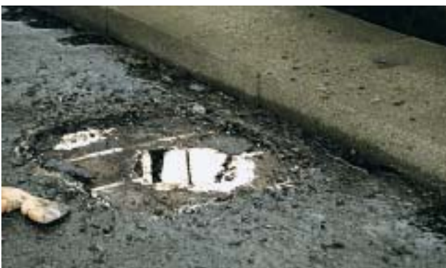
Verlegung auf der alten Abdichtung mit Anschlussdetail; wie hier zu sehen an einer Dachentwässerung.
