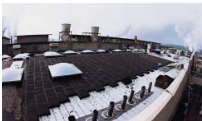
Kompaktdach-Verlegung mit FOAMGLAS®-Platten auf Stahltrapezprofil bei einer Papierfabrik.
