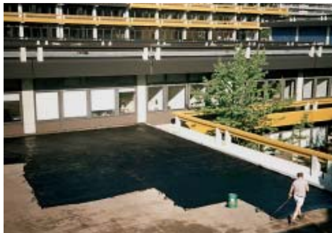
Auf vorhandener und gereinigter Dachabdichtung Auftrag eines Bitumenvoranstrichs.
