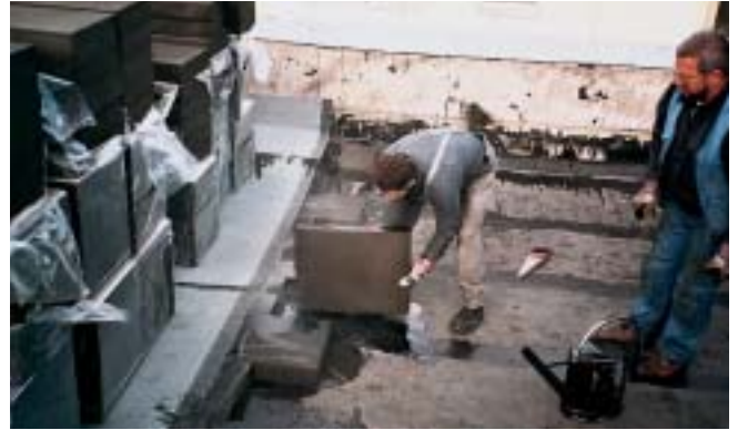
Aufbau der neuen FOAMGLAS®-Dämmung im Kantentauchverfahren zur dampfdichten Verlegung – Stoßfugen inbegriffen.
