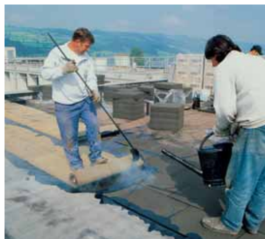
Anbringen der Dichtungsbahn aus Bitumen
