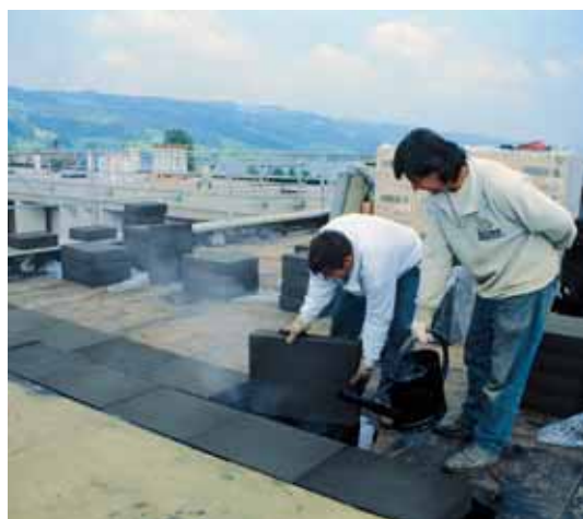
Verlegung von FOAMGLAS®-Platten 45 x 60 cm
