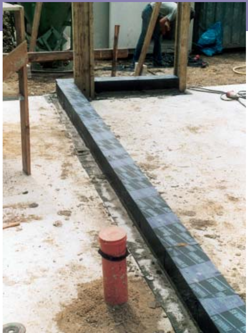
FOAMGLAS®-Perinsul® SL vermeidet nasse Füße im Mauerfuß (keine Kapillarität).
