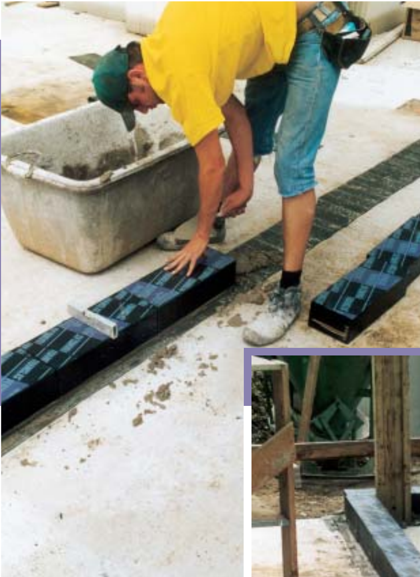
Perinsul® SL-Dämmsteine werden stumpf gestoßen aneinander gereiht und im Mörtelbett versetzt.
